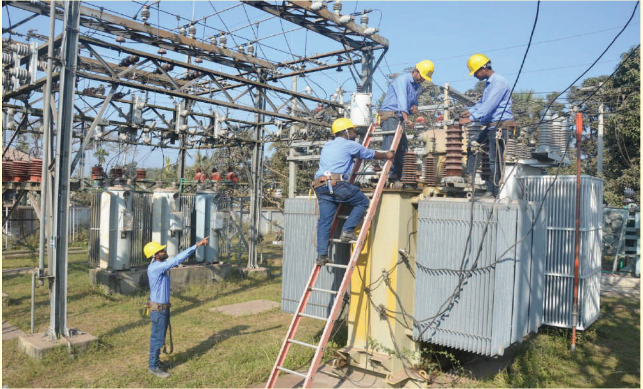
পল্লী বিদ্যুতের সাব-স্টেশন রক্ষণাবেক্ষণ কার্যক্রম
